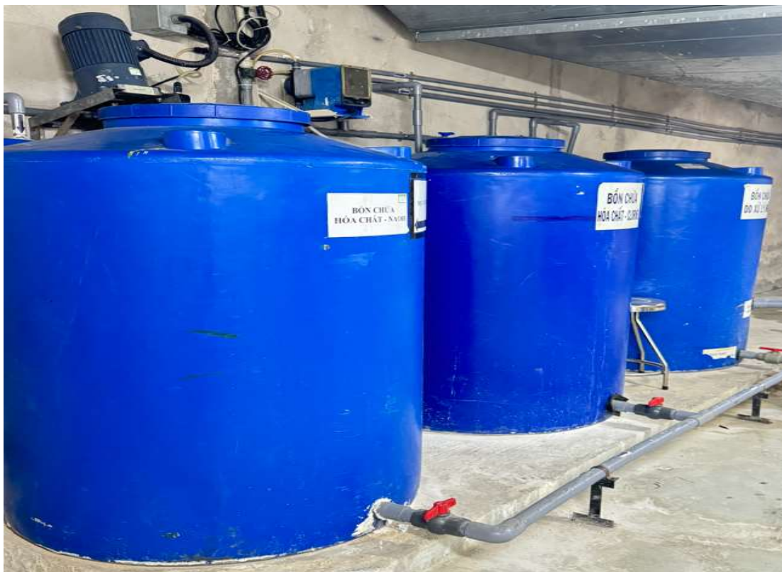
Bồn chứa hóa chất, bơm định lượng
