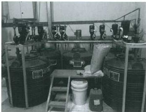
Bồn chứa hóa chất, bơm định lượng
